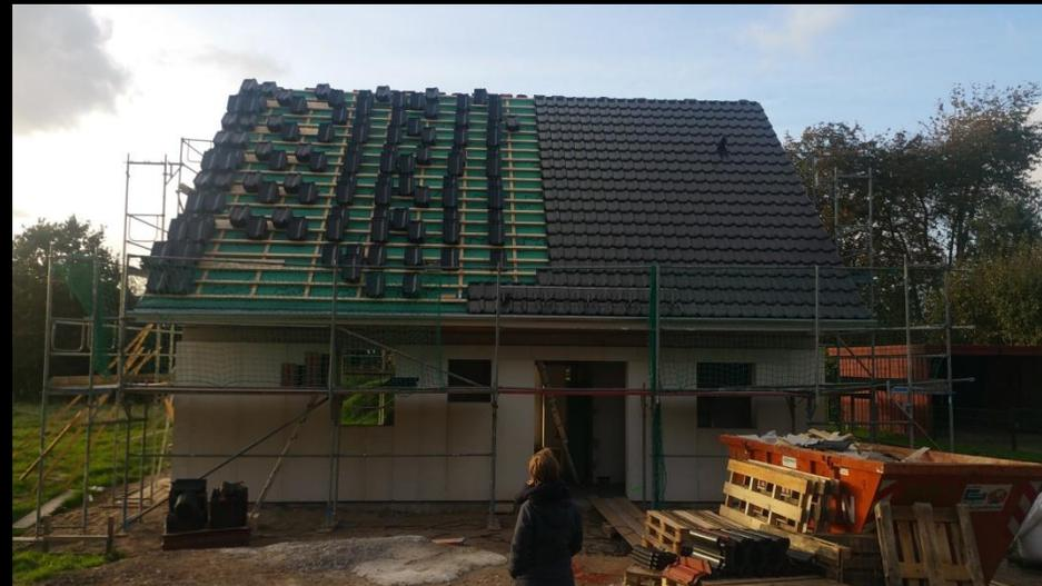
Das Dach wird gedeckt und der Dachüberstand gebaut. In Eigenregie haben wir in den Überstand Kabel für eventuelle Spots verlegt.
